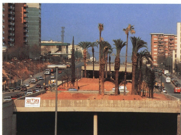
地下化された環状道路 The Underground ring road
